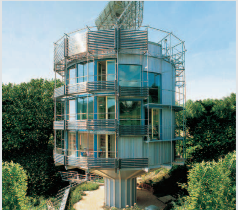
Afb. 43: Heliotrop (in Freiburg, Duitsland) met vacuümbuiscollectoren
